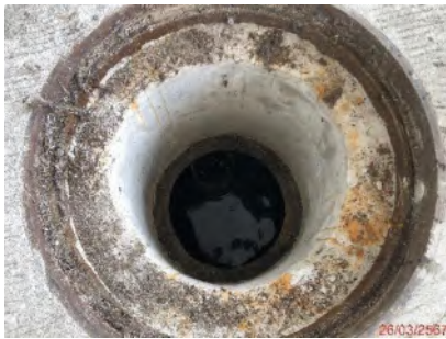
จุดเก็บน้ำทิ้งก่อนเข้าระบบบำบัดน้ำเสียอาคารที่พักผู้โดยสารหลังใหม่ขาเข้า
