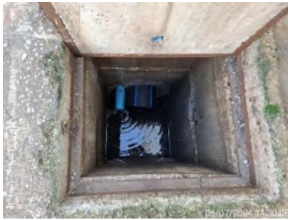
จุดเก็บน้ำบริเวณจุดระบายน้ำเสียหลังผ่านการบำบัดน้ำของอาคารที่พักผู้โดยสารหลังใหม่ขาออก
