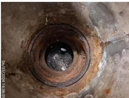
จุดเก็บน้ำทิ้งก่อนเข้าระบบบำบัดน้ำของอาคารที่พักผู้โดยสารหลังใหม่ขาออก
